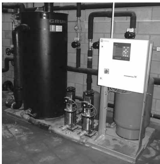
Rys. 47 Przykład rozwiązania niestandardowego układu pompowania wody deszczowej
