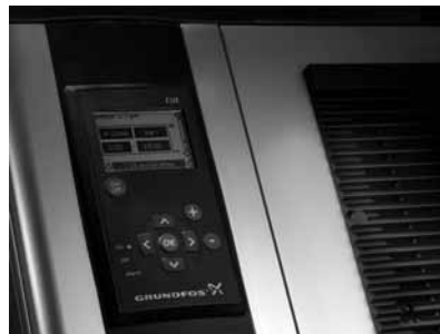
Rys. 24 Panel sterowania CUE
