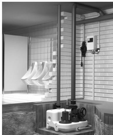
Rys. 27 Przykład montażu agregatu Multilift MOG w studziście w piwnicy budynku
